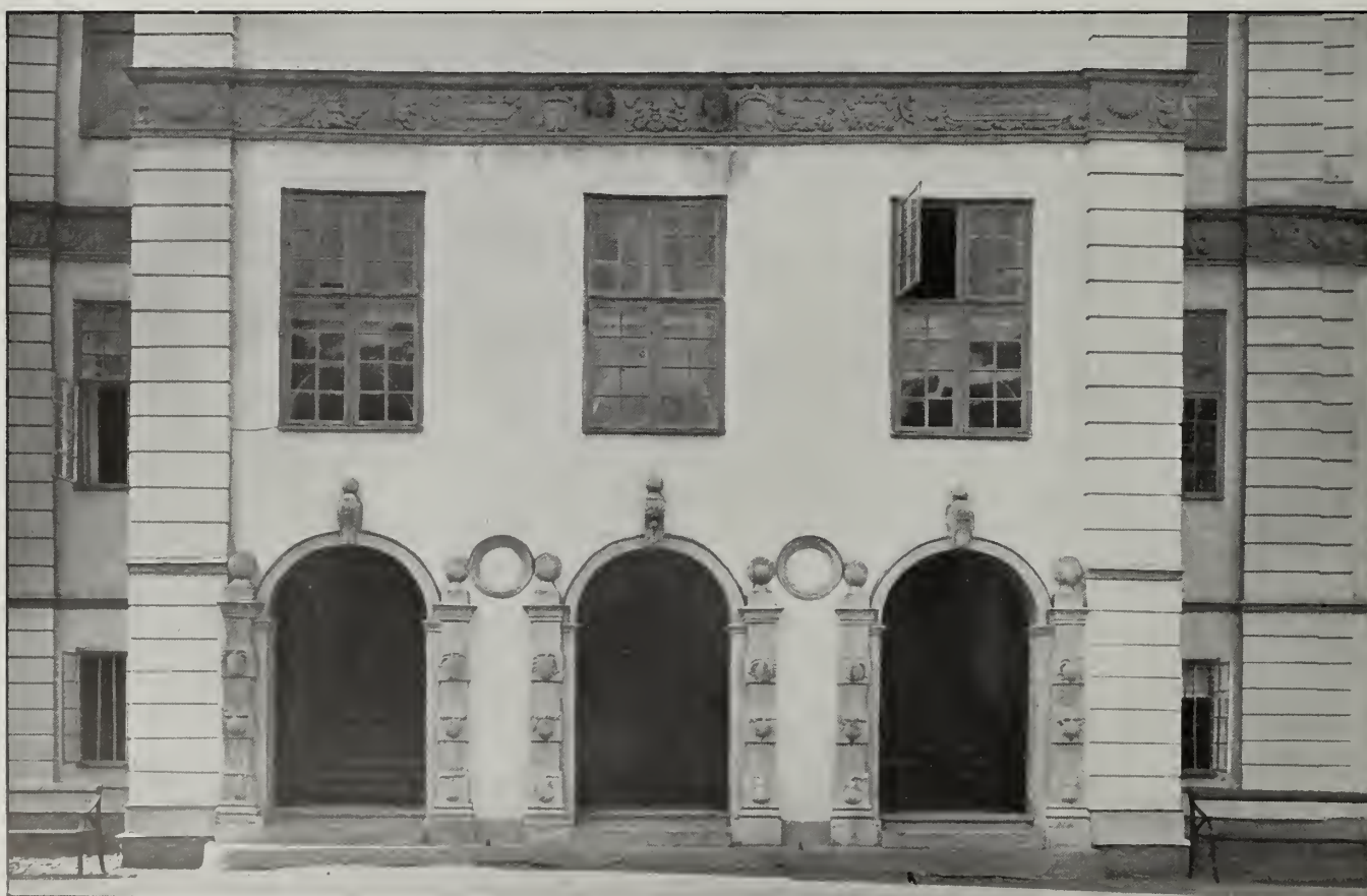
Portalerna å hufvudbyggnadens midtparti.
